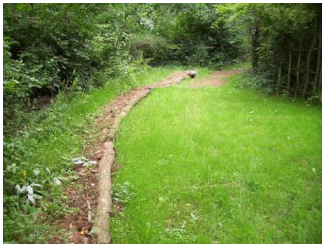
Figura 2.86 - Posa di tronchi e riempimenti in terra per ridurre l'allagamento del sentiero
